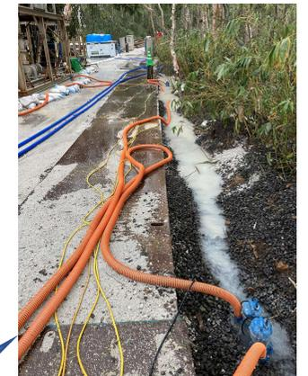
② 現場のニセコアンベツ2号川側へ側溝を設置し、現場からの流出を防止
