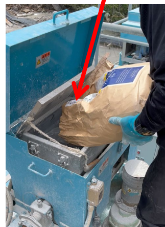
ヒ素除去用 凝集剤投入写真
