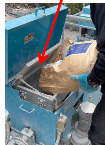
ヒ素除去用 凝集剤投入写真
